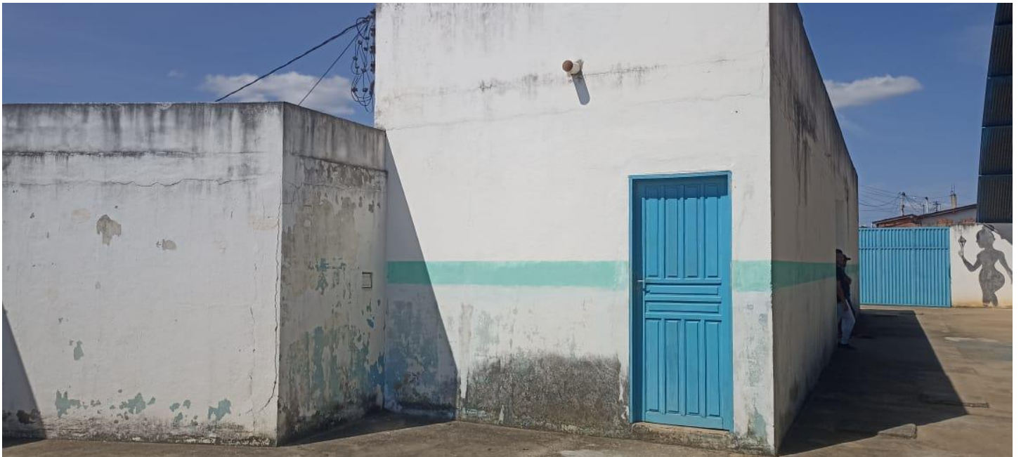
BANHEIRO MASCULINO EXTERIOR
