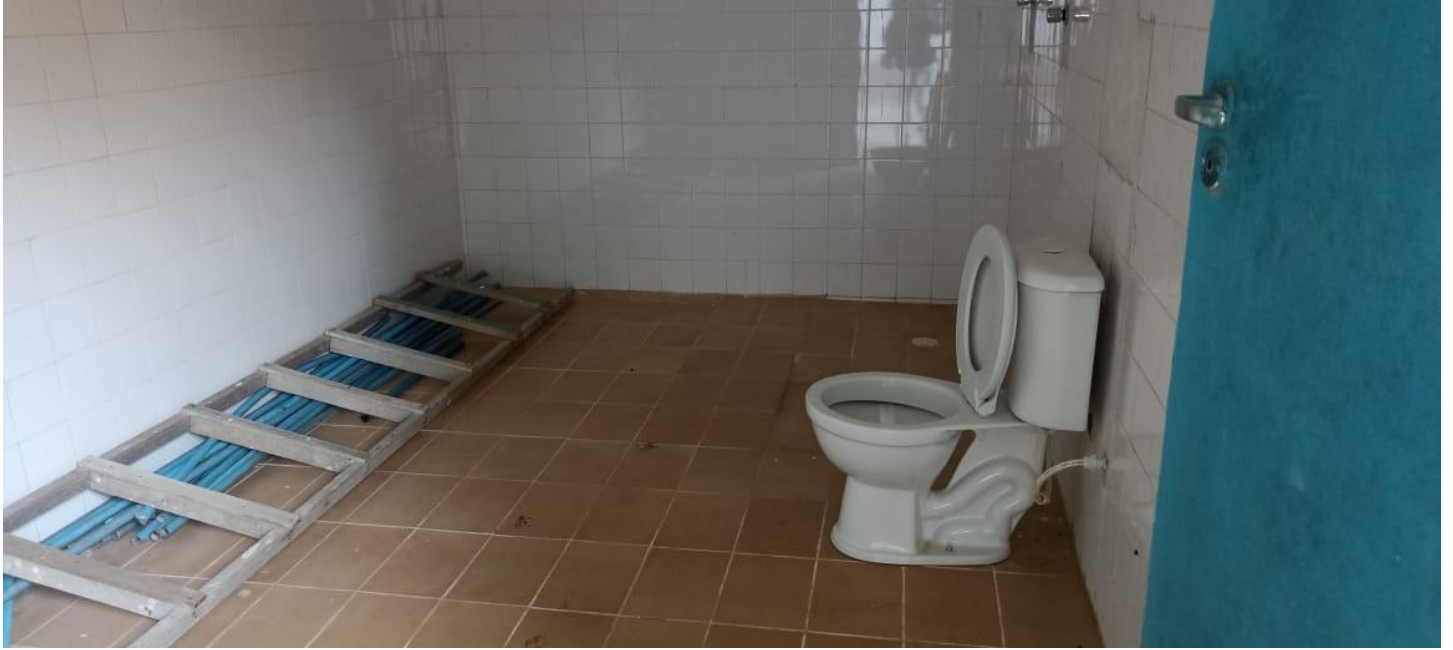
BANHEIRO DO VESTIARIO 02
