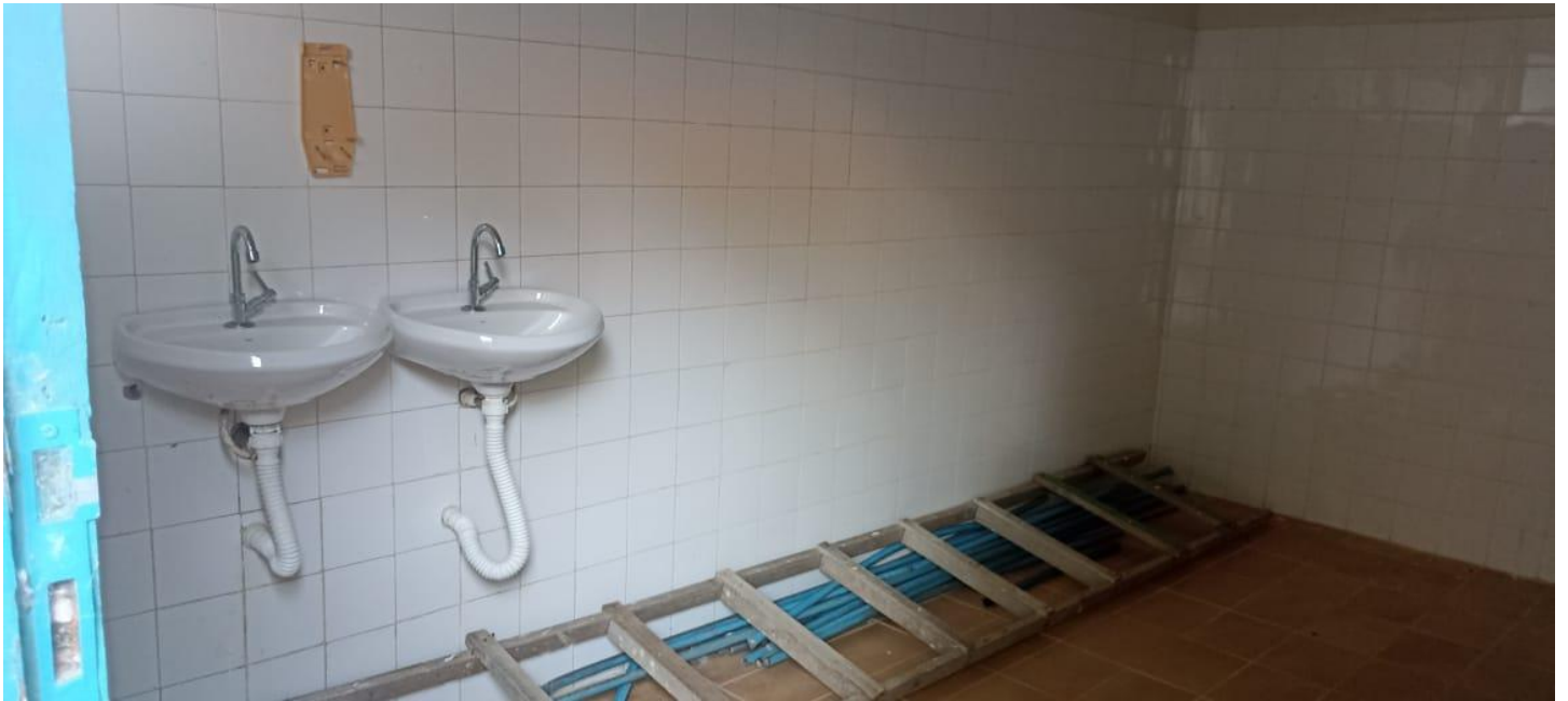
BANHEIRO DO VESTIARIO 02
