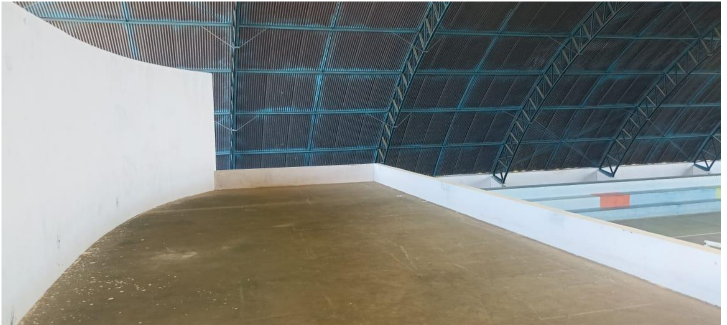
ÁREA SUPERIOR AOS VESTIÁRIOS
