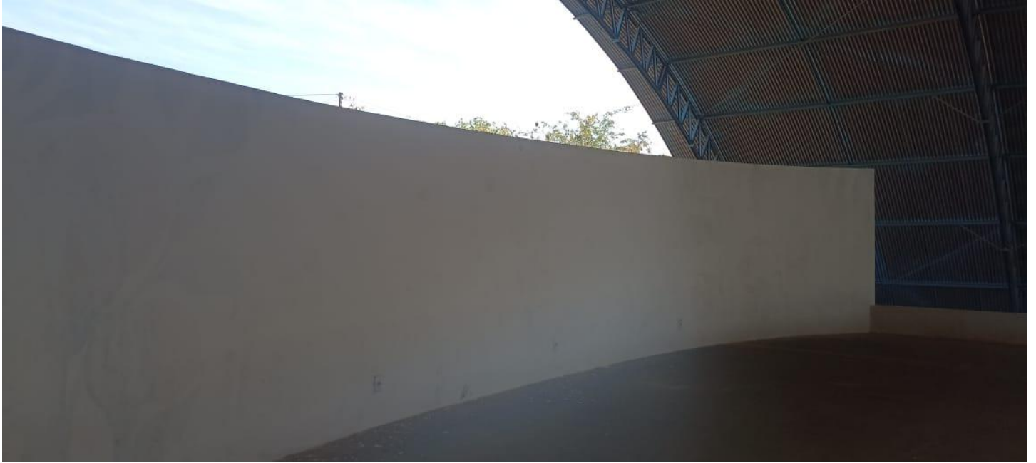
ÁREA SUPERIOR AOS VESTIÁRIOS
