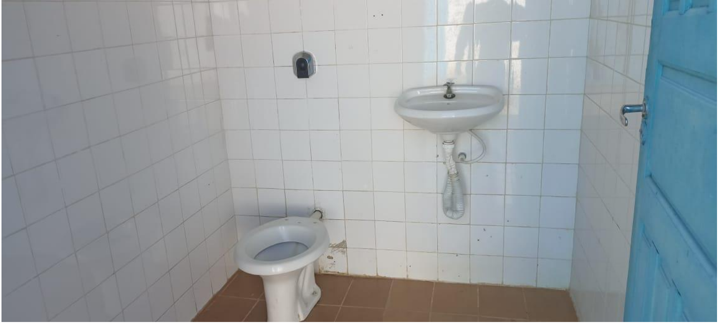
BANHEIRO DO VESTIÁRIO 03
